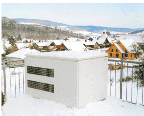
Abbildung 38 (Wärmepumpe, Wärmequelle: Aussenluft)
